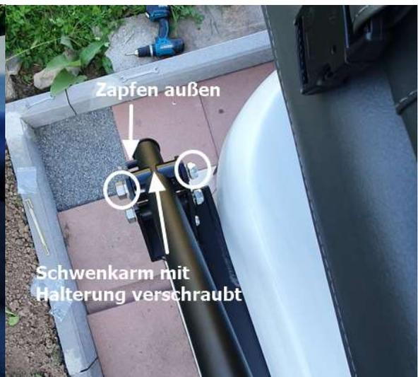
Schraubverbindung Halterung mit Schwenkarm auf beiden Seiten mit Gefühl anziehen.
