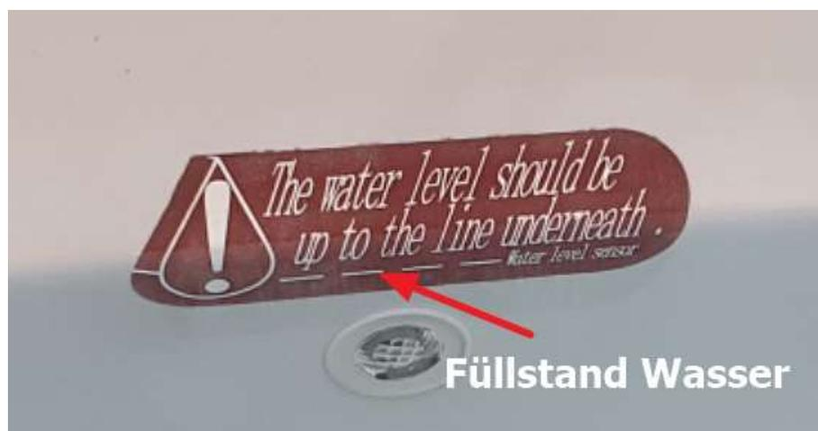
**Whirlpool in Betrieb nehmen. Den Innenraum (z.B. Schläuche, Kupplungen, Pumpen, LED-Beleuchtung) in den nächsten Stunden unter der Acrylwanne auf Dichtheit überprüfen. Die seitlichen Abdeckungen erst nach Prüfung befestigen. Den Wasser-Füllstand in den nächsten Tagen an der gestrichelten Linie „Aufkleber in der Acrylwanne“ kontrollieren!**
